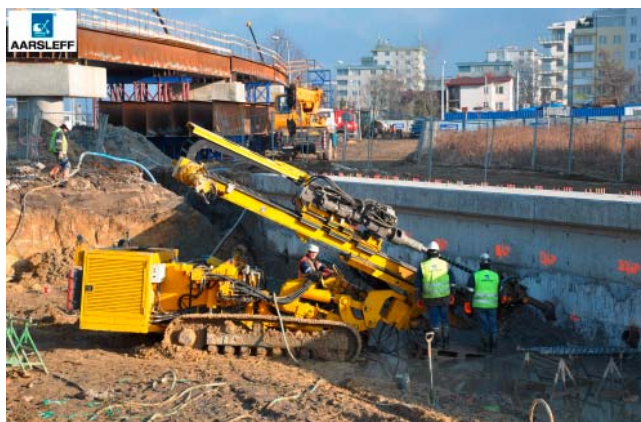
Fot. 1. | Wykonywanie kotew gruntowych. Wiercenie z wykorzystaniem rury osłonowej
